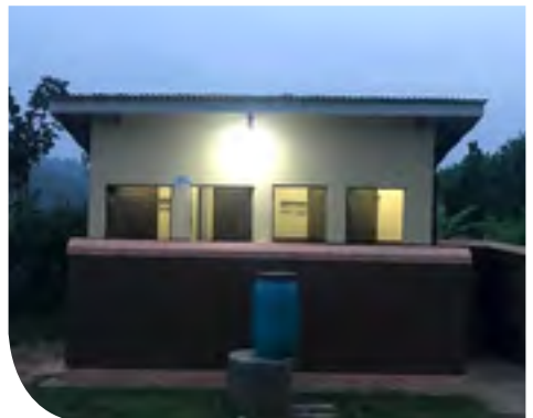
Der Toilettengang endlich bei Licht
